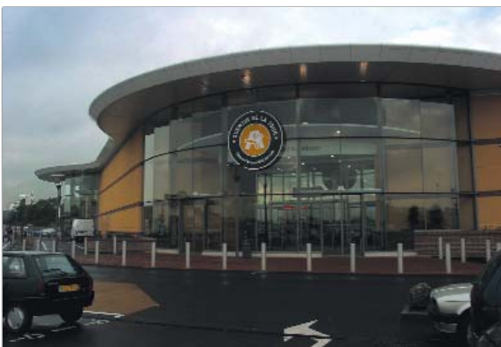
de ces entrées de ville où les alignements de boîtes restent la règle.
